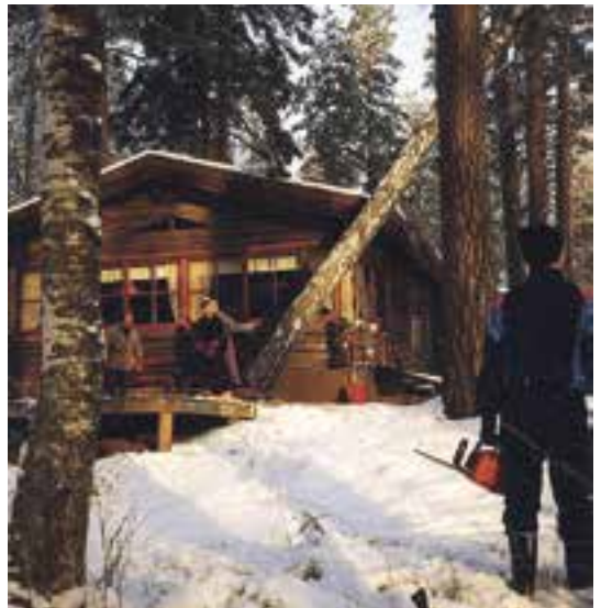
Puita kaadettiin ja ulkoterassi purettiin. Kuva SMMM arkisto.
