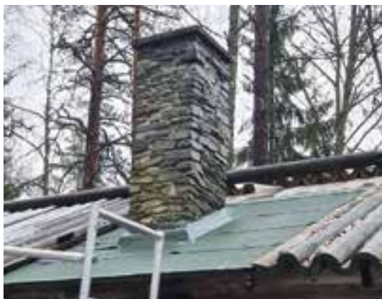
Saunan katon vesieristys varmistettiin. Kuva Pekka Sabari.
