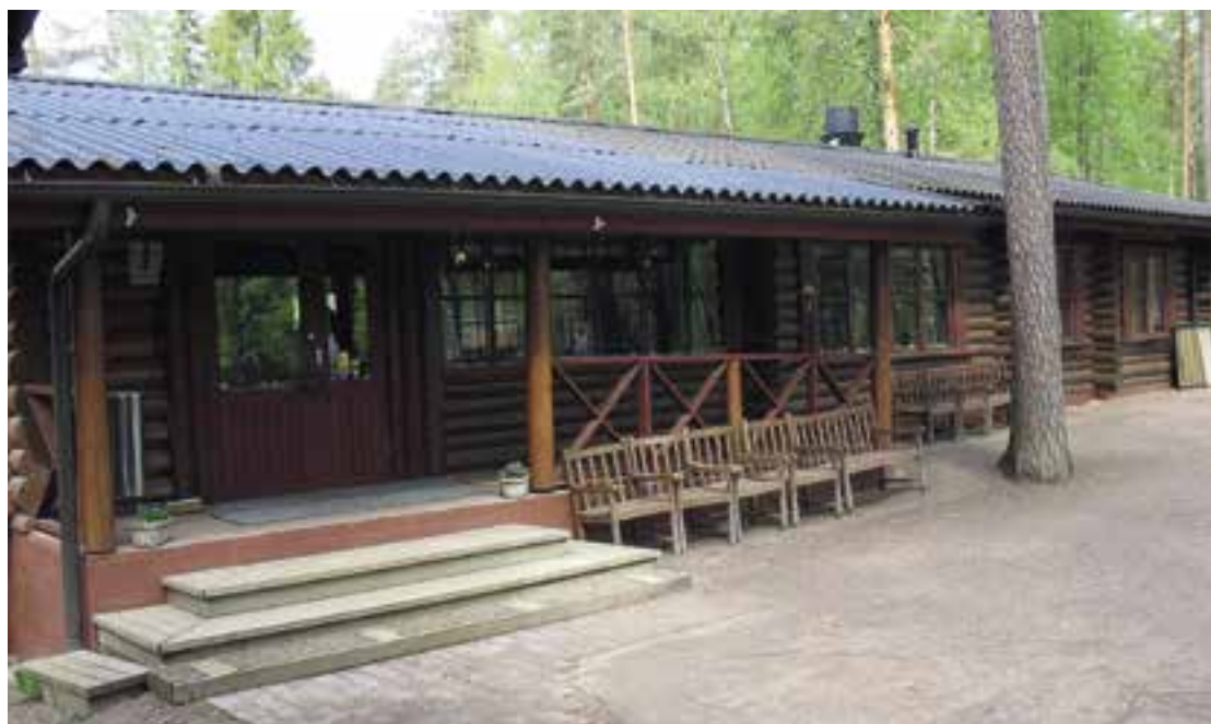
Kahvion laajennusosaan tuli eteinen ja erilliset WC:t naisille ja miehille. Tämä mahdollisti ympärivuotisen ravintolatoiminnan. Kuva Marjatta Abtiainen.
