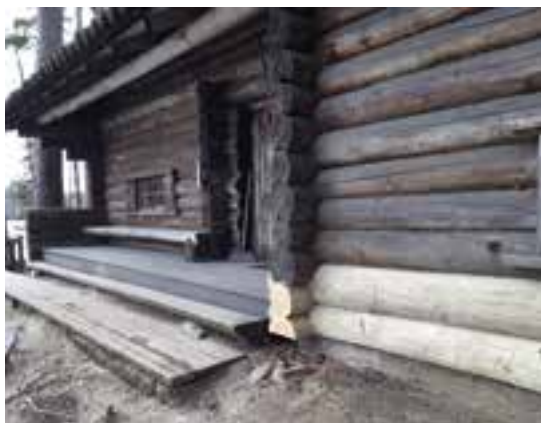
Saunaremontin yhteydessä vaihdettiin kaksi alimmaista hirsikerrosta. Kuva Pekka Sabari.
