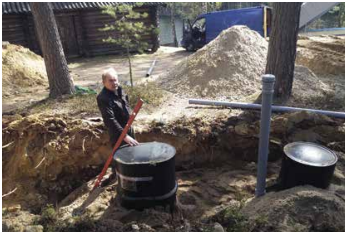
Laaja koko alueen harmaa-vesijärjestelmän remontti toteutettiin vuonna 2019. Kuva Pekka Sabari.
